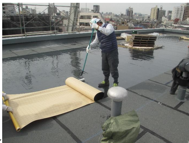
防根層（カナートシャット）の施工
