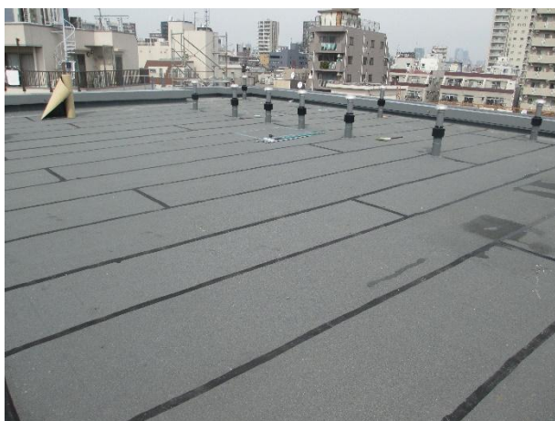
防水層の施工
