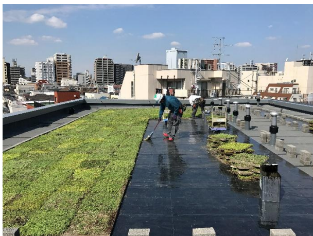
緑化基盤＋緑化の施工
