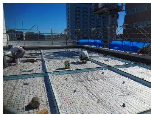
②溶接金網の敷設
